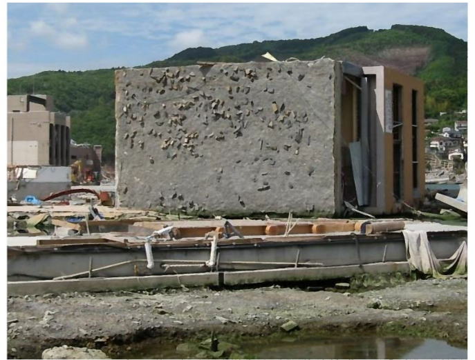
写真 2-1 ベタ基礎 3階建て建物も 津波の力で横転(女川で撮影)
